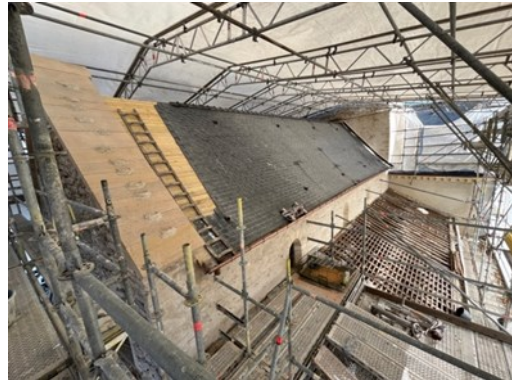
Vue de l'ensemble du chantier
