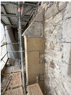
Habillage d'un contrefort terminé (collatéral Sud)
