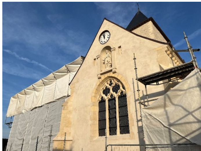
Façade du bras sud du transept restaurée et pose du parapluie sur la nef
