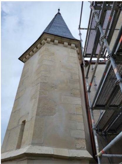
Vue en contreplongée de la tourelle d'escalier dégagée de son échafaudage
