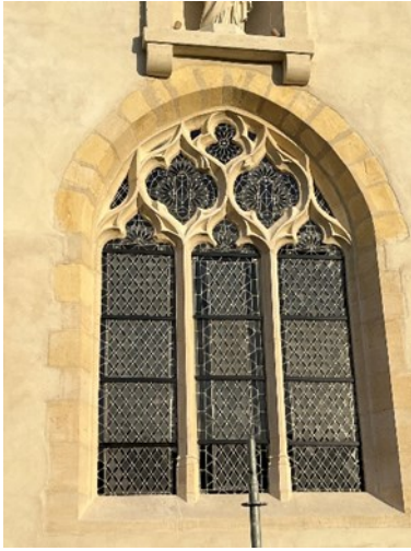
Baie du bras sud restaurée et verrières reposées
