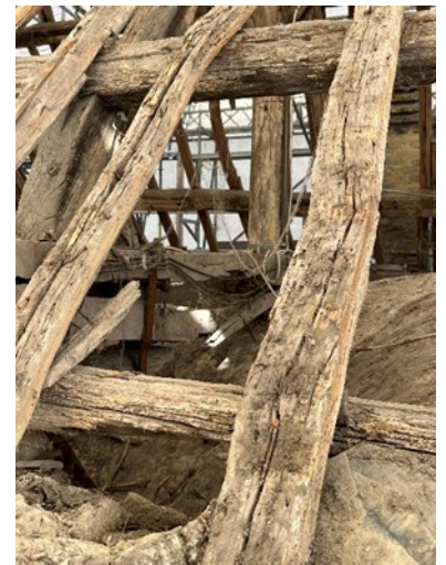
Charpente de la nef après démontage de la couverture en ardoise. Une partie des bois sera récupérée et réemployée. La structure existante laisse apparaître les poutres supportant la voûte d'origine en bois (remplacée au 19 ème siècle)
