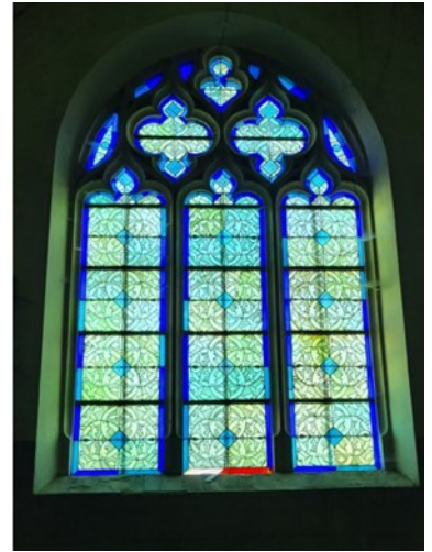
Repiquage et nettoyage de la verrière du bras nord du transept
