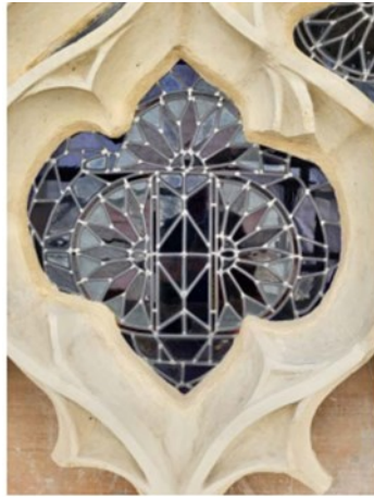
Détail du remontage des verrières des réseaux supérieurs de la baie du bras sud, avec les quadrilobes
