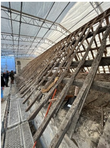
Charpente de la nef après démontage de la couverture en ardoise. Une partie des bois sera récupérée et réemployée. La structure existante laisse apparaître les poutres supportant la voûte d'origine en bois (remplacée au 19 ème siècle)
