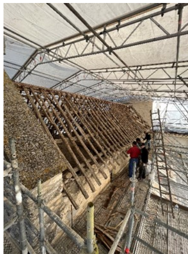
Charpente de la nef après démontage de la couverture en ardoise. Une partie des bois sera récupérée et réemployée. La structure existante laisse apparaître les poutres supportant la voûte d'origine en bois (remplacée au 19 ème siècle)
