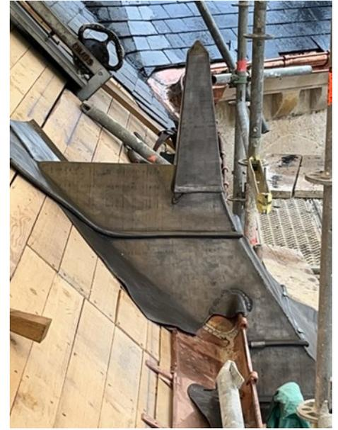
Mise en forme du poinçon de la sacristie, façonnage en plomb et pièce terminée
