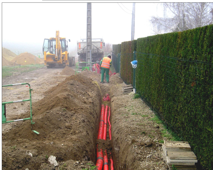
Enfouissement des réseaux EDF et Télécoms
