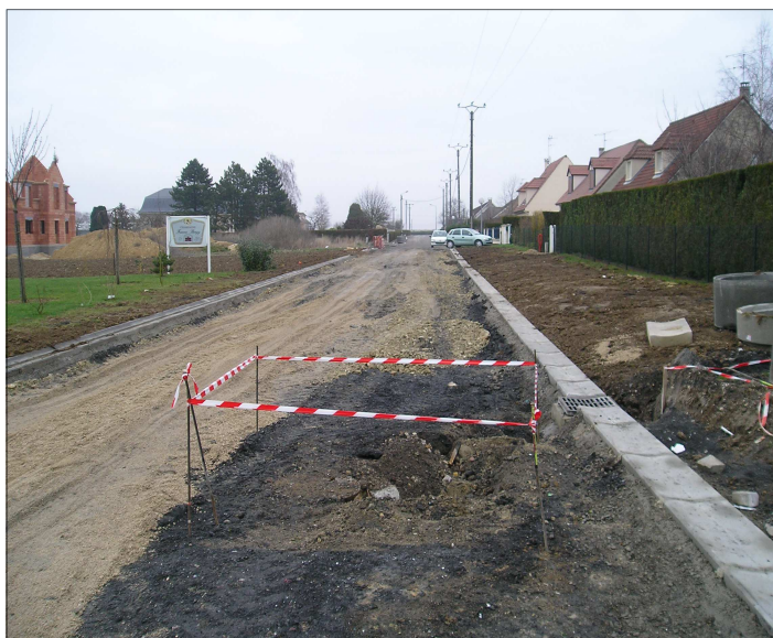
Aménagement de la chaussée et pose de bordures
