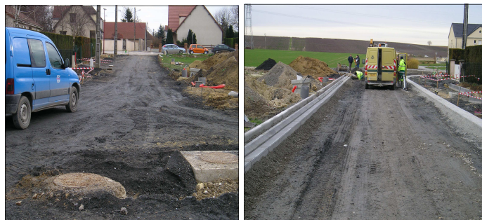
Pose des bordures et aménagement des trottoirs
