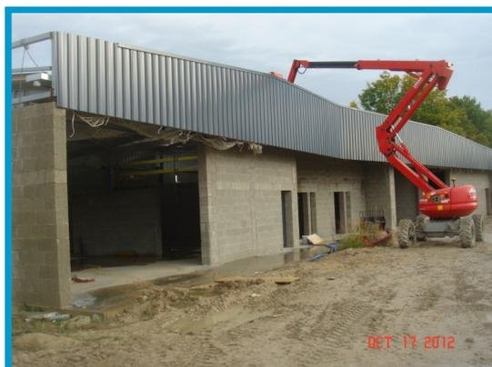
**Avancement des travaux :** la couverture est en cours de finition. A partir du 29 octobre, la pose des menuiseries extérieures aura lieu, suivie par la pose des menuiseries intérieures.
