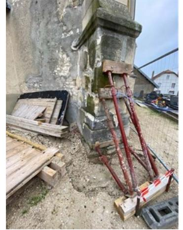
Après la reprise des fondations (sauf sur la partie décrite ci-avant), les travaux de restauration du bras Nord du transept ont véritablement débuté en octobre 2021. La purge des enduits et joints de ciments a mis en évidence l'état très dégradé des murs de cet ensemble et plus particulièrement ceux de la tourelle.
