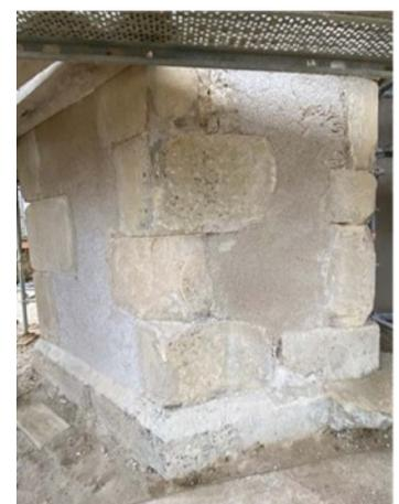
Détail des importantes pertes de matières dans le corps de maçonnerie de la tourelle, des reprises de maçonnerie et du dégrossi d'enduits
