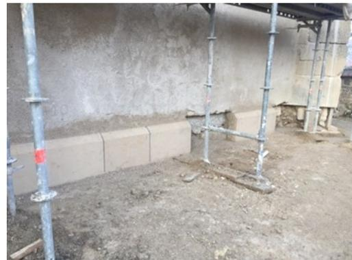
Soubassement pignon du bras nord. Détail des pierres de soubassement posées en pied de gouttereau Est du bras Nord du transept. Pose sur lit de mortier, empochement dans l'épaisseur des maçonneries et solin venant boucher la partie supérieure
