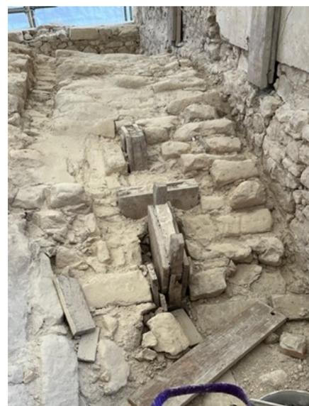
Vue partielle de l'extrados de la voûte et de l'emplacement du mécanisme de l'horloge avec une structure en bois bloquée dans la voûte (pour supporter ce mécanisme très lourd)
