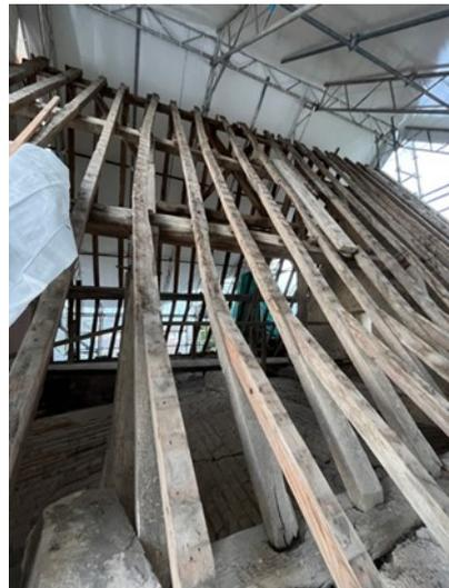
Dépose de la couverture et de la charpente du bras Nord : l'état de la charpente a nécessité son démontage et le remplacement d'une partie de celle-ci tout en conservant un maximum de bois
