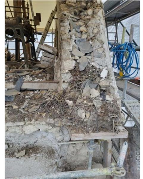
Dépose de la couverture et de la charpente du bras Sud : état avant nettoyage et descente du mécanisme de l'horloge, mis à l'abri dans l'église
