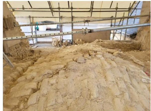
État après nettoyage de l'extrados de la voûte du bras Sud, laissant apparaître une fissure connue de la voûte
