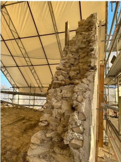
Vue de profil du pignon du bras Sud. Confortement en cours par injection de coulis et projection de mortier
