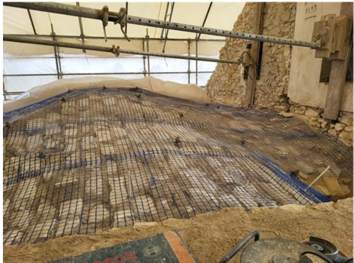
Pose de l'armature en fibre de verre sur l'extrados de la voûte du bras Sud, avec tiges fibrées goujonnées dans les voûtes et treillis de renfort en fibre de verre
