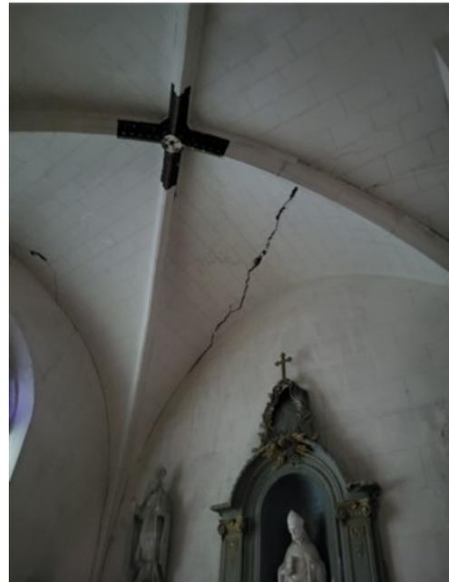
Fissure traversante de la voûte visible, côté Est au niveau des voûtains en briques
