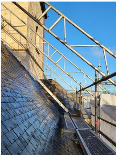
Vue latérale du rampant Est du bras Sud et des poutres treillis formant l'ossature du parapluie
