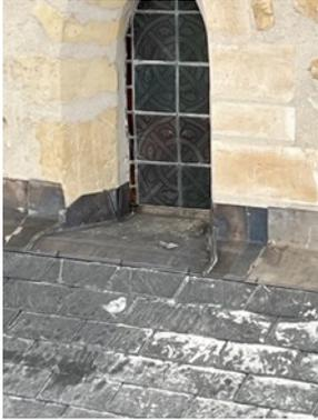
Vue rapprochée d'une baie du gouttereau nord de la nef dont l'appui et la base sont en cours d'habillage. Un glacis plâtre est réalisé pour recevoir la couverture en plomb. Une remontée le long du vitrail assure l'étanchéité.
