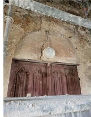
Tympan dégagé et fissuré du portail occidental. La pierre de tympan est entièrement fissurée. Elle sera déposée et remplacée par une pierre unique.
