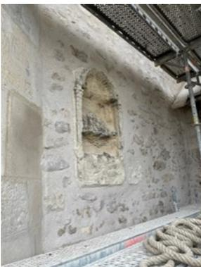
Enduit pierre réalisé au niveau de la façade occidentale. Détail du pignon du collatéral nord. Le bas-relief sera purgé et consolidé, avec la réalisation de petits solins pour faciliter l'évacuation des eaux de pluies.
