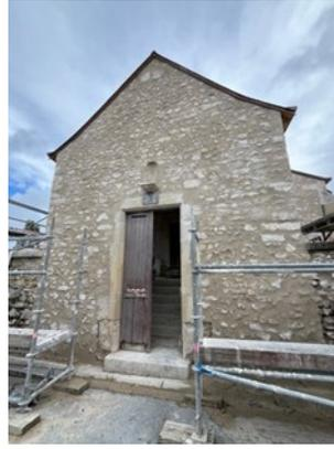
L'enduit recouvrant, prévu initialement sur l'avant-porche a été remplacé par un enduit à pierres vues pour avoir une harmonie avec le mur d'enceinte du cimetière qui vient encadrer le pignon.
