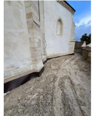
Excavations réalisées pour la mise en place du réseau de drainage périphérique. Les massifs de fondations dégagés ont fait l'objet d'un contrôle soigneux, d'un refichage, coulinage et jointoiement.
