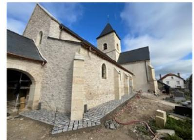
Réalisation du revers pavé le long du collatéral sud et vue du contrefort de l'angle Sud-Est traité avec soin, avec une taille à onglet précise des pavés.
